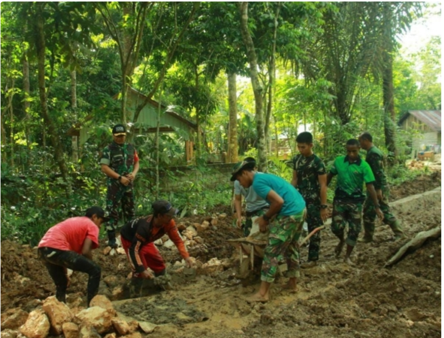
Dansatgas TMMD Kodim 1008 /Tabalong Tinjau Progres Pembuatan Badan Jalan
